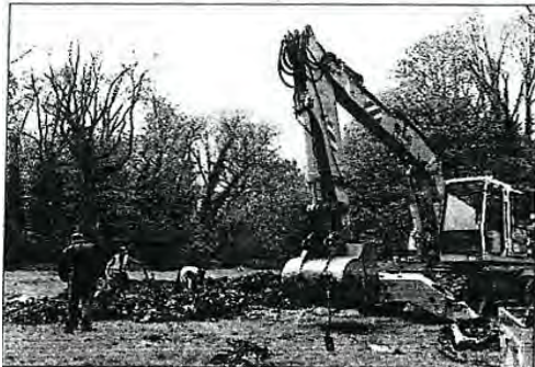
Il a fallu creuser à 4 m pour retrouver les éléments
